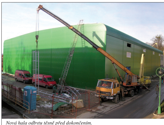
Nová hala odbytu těsně před dokončením.
