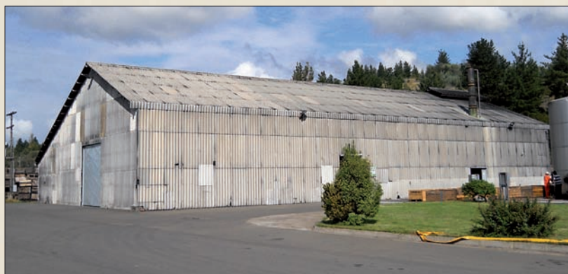
Nahoře rekonstruovaná výrobní hala R. JELÍNEK, dole foto budovy před rekonstrukcí.
